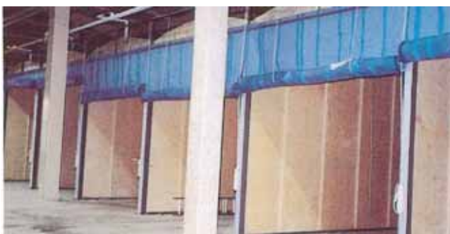
ハイコンパネル養生室
